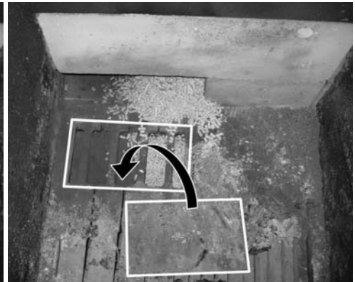
Abb. 9 Entaschung (optional) nicht vorhanden: Abdeckblech in Ausnehmung einlegen.
